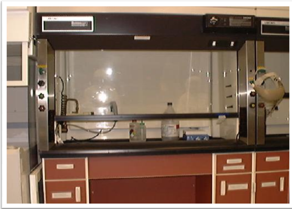
شكل ٥ : كابينة شفط الغازات والأبخرة السامة (Fume Hood)
